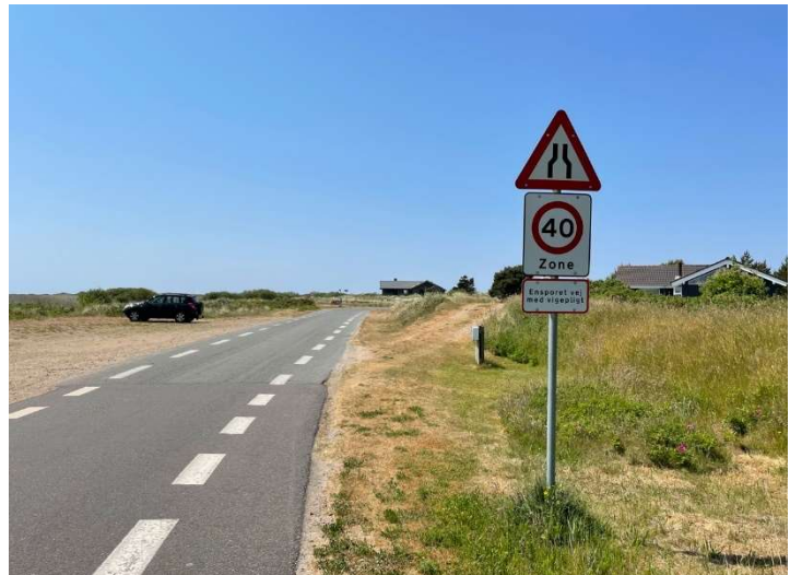
Figur 3 - Skift i længdeafmærkning ved overgang til hastighedszone på 40 km/t.
