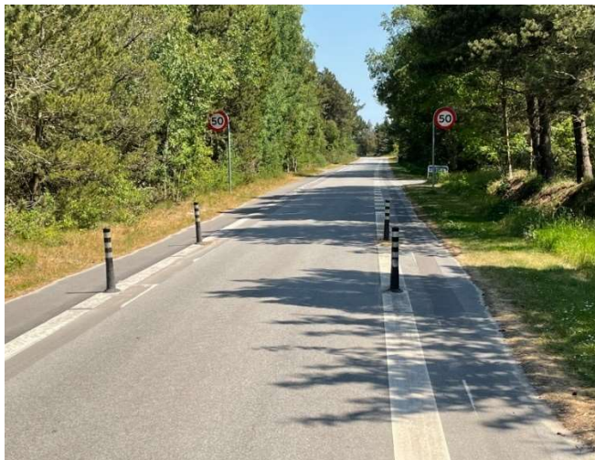
Figur 4 - Fartdæmpere på Småfolksvej ved indsnævring til et spor med steler i kantbanen.
